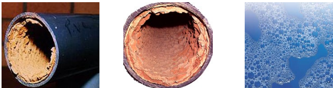
Figura 2. Tuberías de agua potable incrustadas por la presencia de sarro e inhibición de la formación de espuma de jabón.
